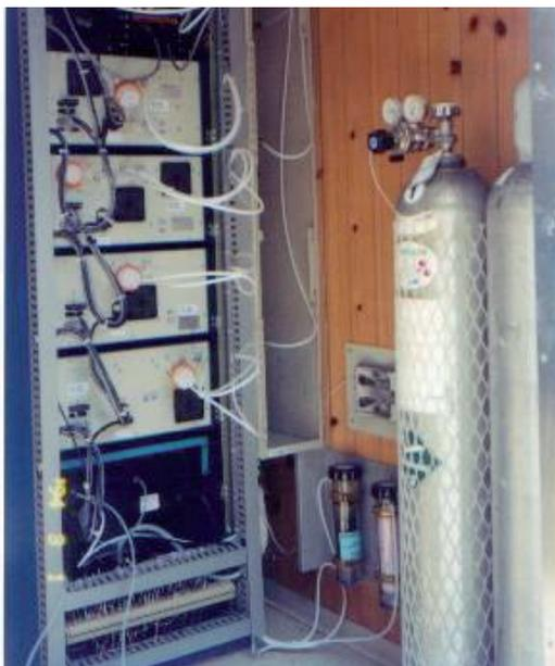
*Figura 9. Cilindros de gases comprimidos sin sujeción en una estación.*
